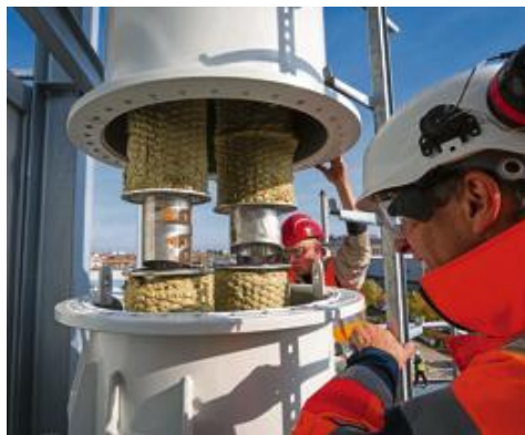
La plate-forme Gaya à Saint-Fons entrera en service avant la fin 2016. Photo Kaboch'Arts
