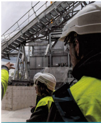
Zone de préparation de la biomasse de deuxième génération.
